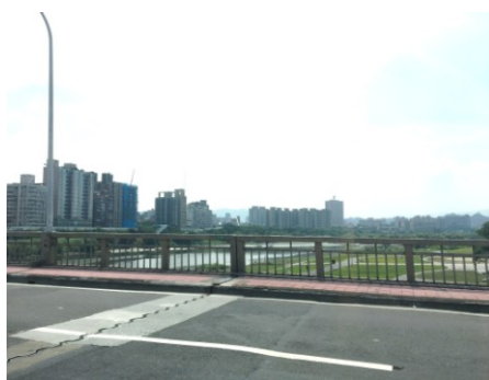
跨越新店溪通往台北市的中正桥
