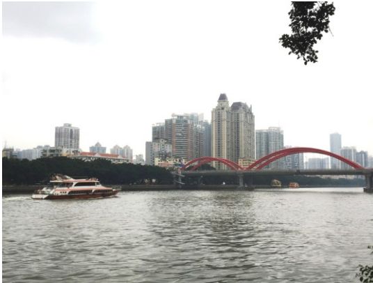
珠江东堤段解放大桥
