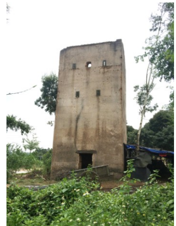
遂溪县路过的炮楼遗迹
