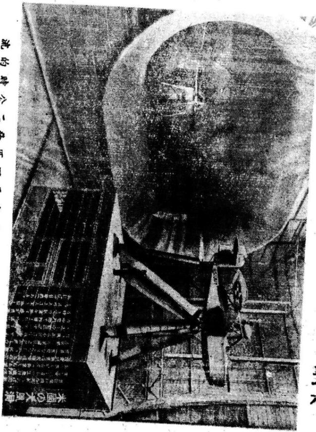
風洞中徑十四公尺螺旋直徑十公尺音速一千四百匹能發出二百公里時速的氣流
