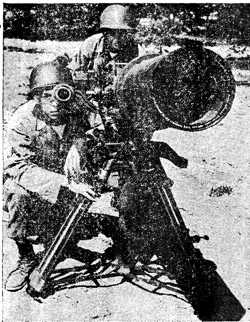
美國陸軍通信兵系隊 Corps 現已發明了一種裝有一百英吋鏡頭長距離新型照相機。這種照相機，可深入大氣裏面的濛汽而在它的通視界以內，攝取三十英呎距離的精細景緻。這種照相機需要兩個人操作。這種新型軍用照相機，將用以攝取平常的照相鏡不能取得的相片，亦可以攝取航空照相不能攝取的相片，這種四元照相鏡的重量，約有四十磅，它的縱深是二英呎，中徑是九英吋又二分之一。可以攝照距離一百英吋的照相鏡應保持固定不動的位置，而移動鏡箱，或照相機的後部以便於將所要攝照的景象誘導到正確的對光位置。
