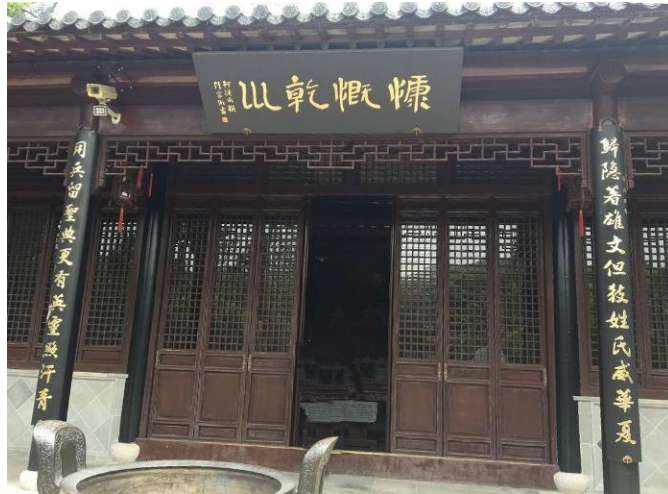
⑭ 新建〈孙武子祠〉享堂正門
